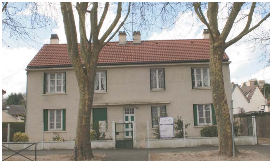
Les travaux démarrent au 126 rue Saint Brice.
